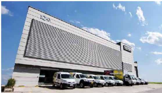
Sede Principal Kaeser Compresores
